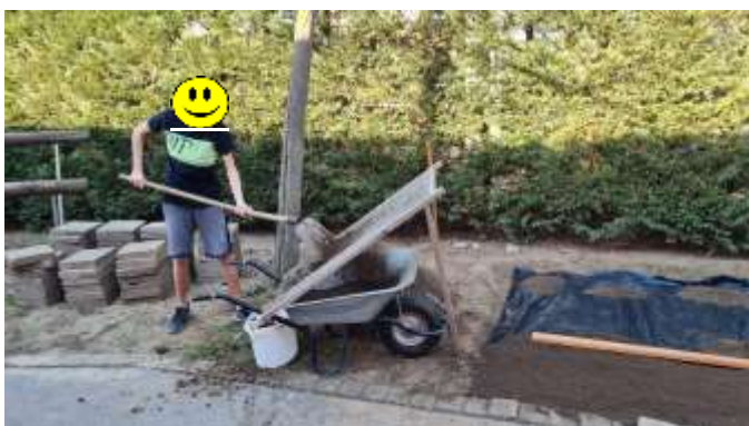
Hier wurde die ausgehobene Erde von einer der Jugendlichen gesiebt und von Steinen und Wurzeln befreit.
